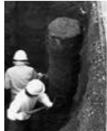
写真1 改良柱体の掘起し状況
