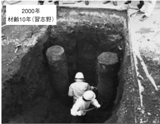
写真2 改良体の掘り出し状況
