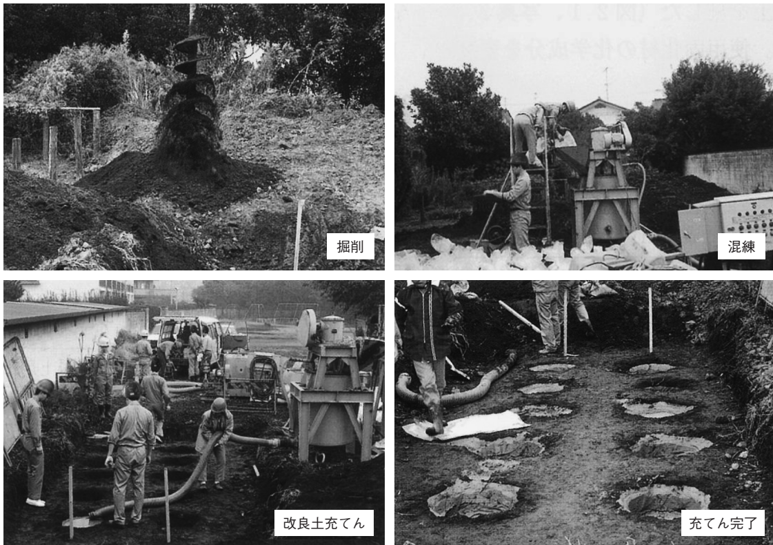
写真1 試験施工の状況(1990年)
