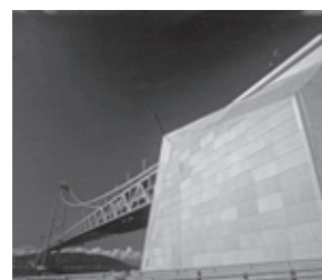
明石海峡大橋
