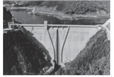
島地川ダム/RCD工法
