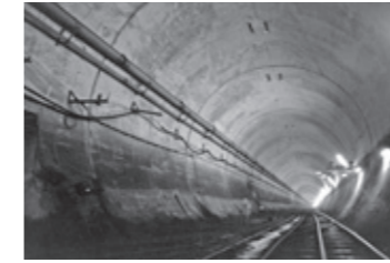
青函トンネル
