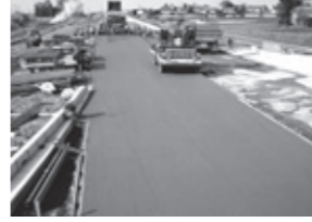
転圧コンクリート舗装/RCCP
