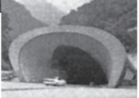
関越自動車/関越トンネル
