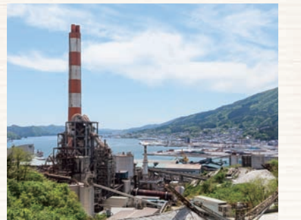
太平洋セメント大船渡工場。東日本大震災で2基のキルンも甚大な被害を受けたが、発生3か月後には高台のキルンで災害廃棄物処理を開始。海岸近くで冠水被害を受けたキルンも年内に復旧し、災害廃棄物を処理した。 [写真提供]太平洋セメント
