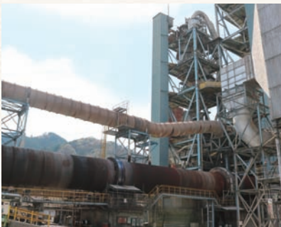
住友大阪セメント栃木工場。ふだんから様々な産業廃棄物を活用している。1450℃もの高温のキルンで焼成、有害物質は完全に分解され、二次廃棄物も出ない。 [写真提供]住友大阪セメント
