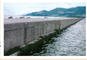
小樽港・北防波堤(北海道小樽市) 明治30～41年にかけて小樽港の湾内と外洋との間に築造された防波堤。長さは約1300mに及ぶ。コンクリートブロックを斜め積みする当時の最新技術を用い、波力による崩壊を防いだ。日本海の冬の荒波に耐え、未だ現役である。[写真提供]北海道開発局
