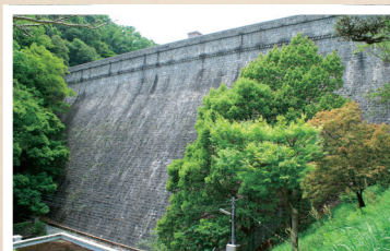
布引五本松ダム(兵庫県神戸市) 明治33年竣工。日本初の重力式コンクリートダム。堤高33.3m、堤頂長110.3m、有効貯水容量60万㎡で水道用。阪神淡路大震災でも大きな損傷はなく、明治期の技術力の高さを窺わせる。震災後、大規模堤体補強を経て、今も神戸市民の貴重な水がめである。水道施設全体で国の重要文化財。[写真提供] 神戸市水道局
