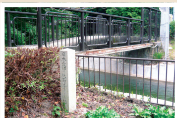
琵琶湖疏水 第11号橋(京都府京都市) 明治36年完成。この小さな橋(橋長約7.3m、幅約1.5m)が日本初のRC橋だ。琵琶湖第一疏水の第三トンネル東口にあるメラン式弧形桁橋。国産セメントを試験的に使い、専用品がなかった鉄筋はロッコのレールで代用。欄干がなく、転落防止の鉄柵が設けられている。
