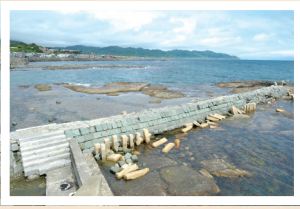
松前港 福山波止場(北海道松前町) 明治8年、同年解体された松前城の石垣を使って竣工。明治25年からの補修工事の際、石の間にコンクリートを詰める「練積み」が行われ、ごく初期のセメント使用例として貴重な遺構。
