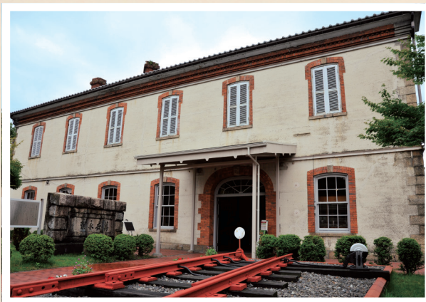
旧長浜駅舎(滋賀県長浜市) 明治15年、敦賀線の起点駅として鉄道開通とともに竣工。現存する日本最古の駅舎で木骨構造の石灰コンクリート造。新橋横浜間を鉄道が走ったわずか10年後で、「陸蒸気」を見ようと大勢の人が集まった。今は長浜鉄道スクエアとして公開。
