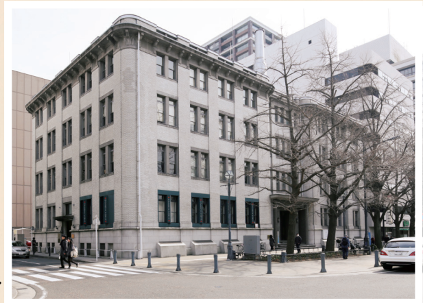
旧三井物産横浜ビル(現・KN日本大通ビル)(神奈川県横浜市) 明治44年竣工。日本初の全RC造の事務所ビルで、世界的にも貴重な建築。竣工12年後の関東大震災で横浜周辺の建物は大きな被害を受けたが、この建物はビクとせず、RC造の頑丈さを印象づけた。
