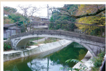
琵琶湖疏水 第10号橋(京都府京都市) 明治37年完成。11号橋からさらに数百メートル東側の第二トンネル東口にある。こちらは日本初の実用RCアーチ橋(橋長8m)。この橋は欄干がつけられており、優美なアーチ形は健在だ。
