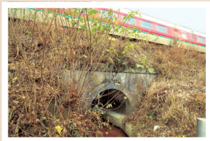
島田川暗渠(島根県安来市) 明治40年完成。鉄道用として造られた日本初のRC造の橋梁。JR山陰本線の米子-安来間の線路下を通るアーチ構造の暗渠で、農業用水が流れる。
