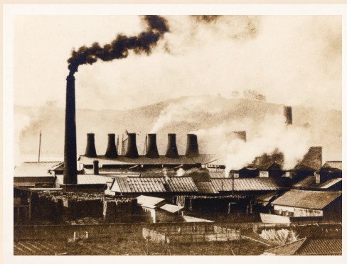
セメント製造会社 中ほどに6本並ぶのがセメント焼成用の「たて窯」。
